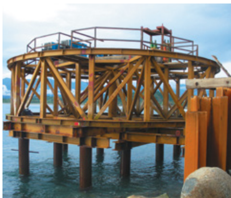
1. Instalación de la guía
