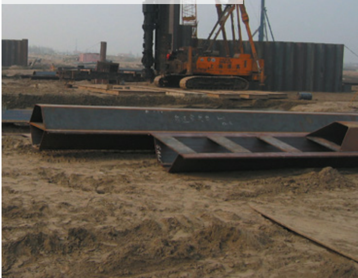
Dique seco de Changxin, Shanghái, China
