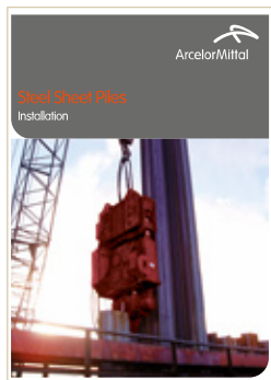
Instalación de tablestacas GB, DE, FR
