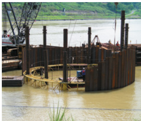
2. Colocación de tablestacas hasta el cierre de la celda
