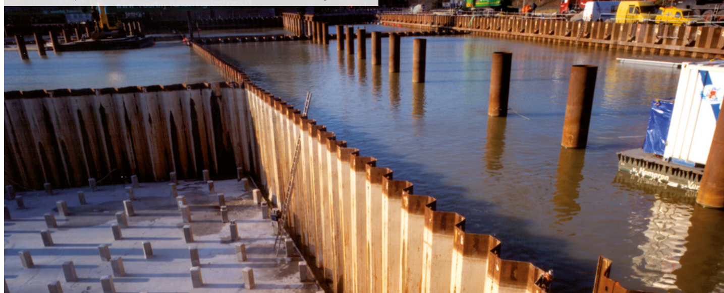
Excavation pour un immeuble de bureaux, Amsterdam, Pays-Bas
