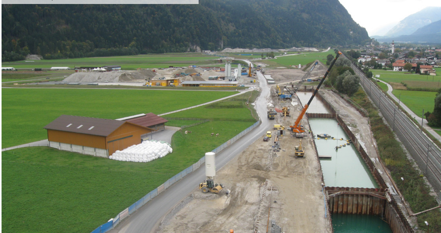
Tranchée temporaire, chemin de fer de Brenner, Autriche
