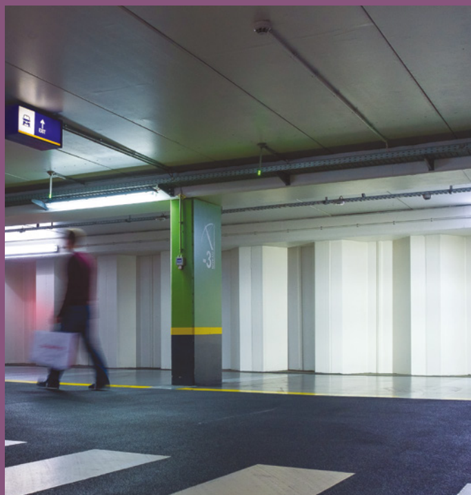
Parking souterrain avec murs de palplanches acier permanents au centre commercial Hopmarkt à Alost, Belgique
