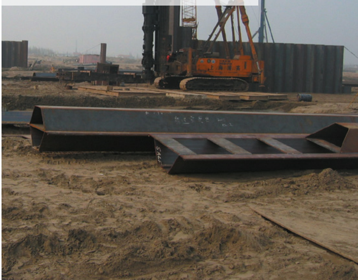
Bassin de radoub Changxin, Shanghai, Chine
