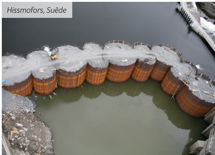
Gabions circulaires avec palplanches raccords à 35^\circ et un ou deux arcs de raccordement
