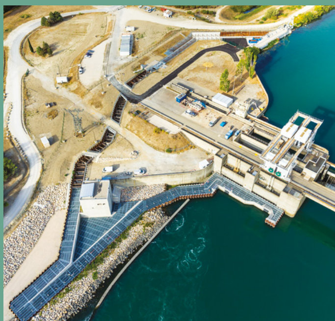
Passé à poissons du barrage hydroélectrique de Sauveterre sur le Rhône, en France, permettant la restauration des voies de migration de plusieurs espèces de poissons et d'animaux sauvages. © Juan Robert
