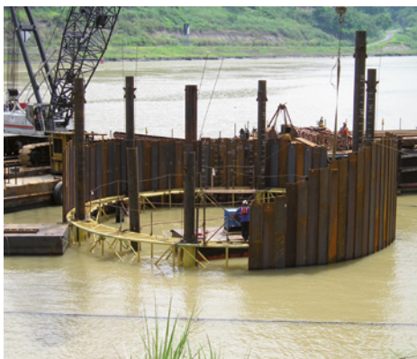
2. Enclenchement des palplanches jusqu'à la fermeture du gabion
