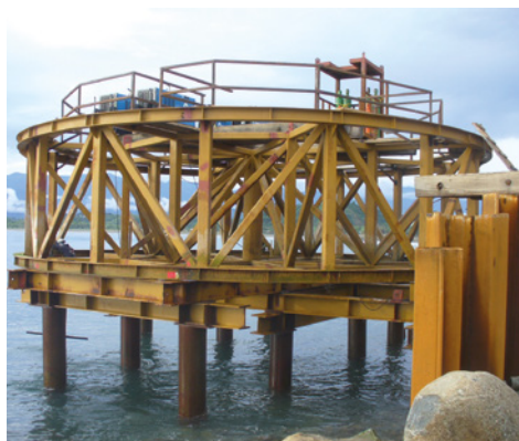
1. Installation du gabarit
