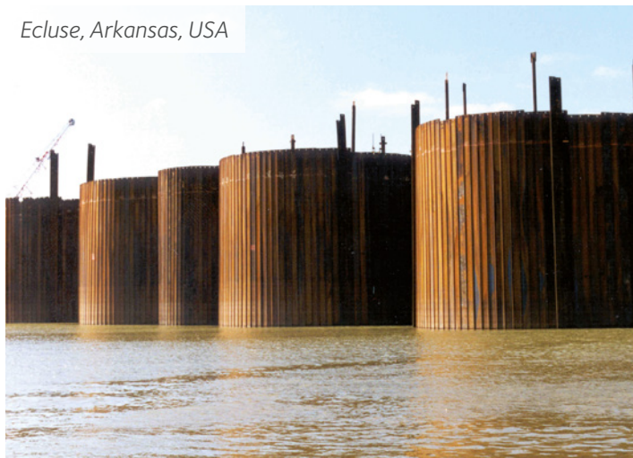
Gabions cloisonnés avec palplanches raccords à 120^\circ
