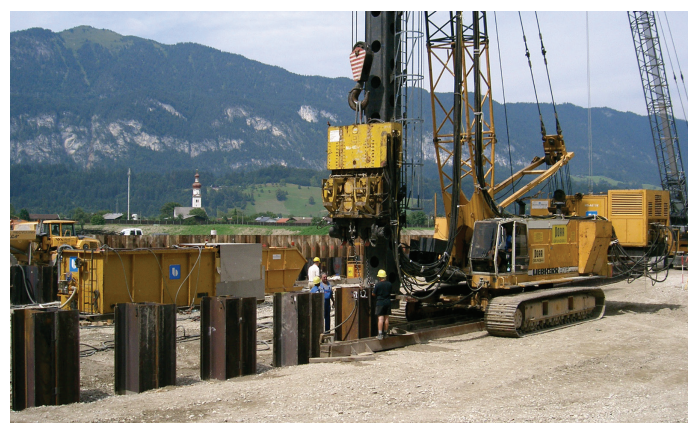
Fig. 11. Guía con un solo nivel y equipo de hinca con un mástil guía fijo.
