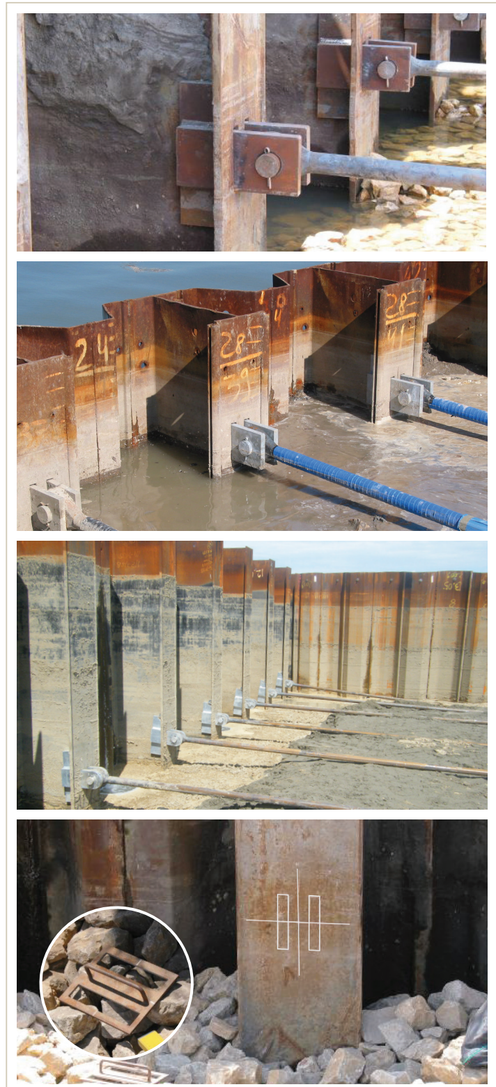
Fig. 5. Instalación de los conectores en T en obra.
