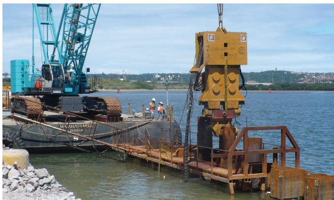
Fig. 10. Detalle del sistema de guiado de los HZ-M.
