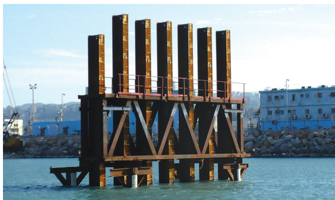
Fig. 9. Estructuras guía y su sistema de soporte auxiliar.
