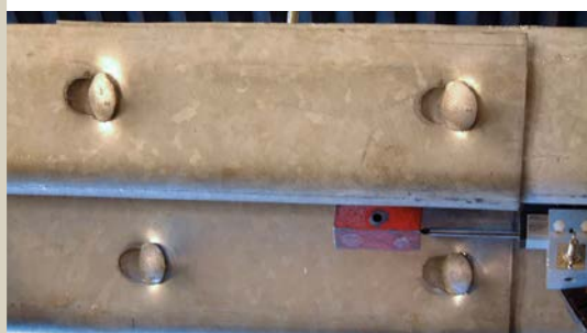
Испытание соединений между балками
